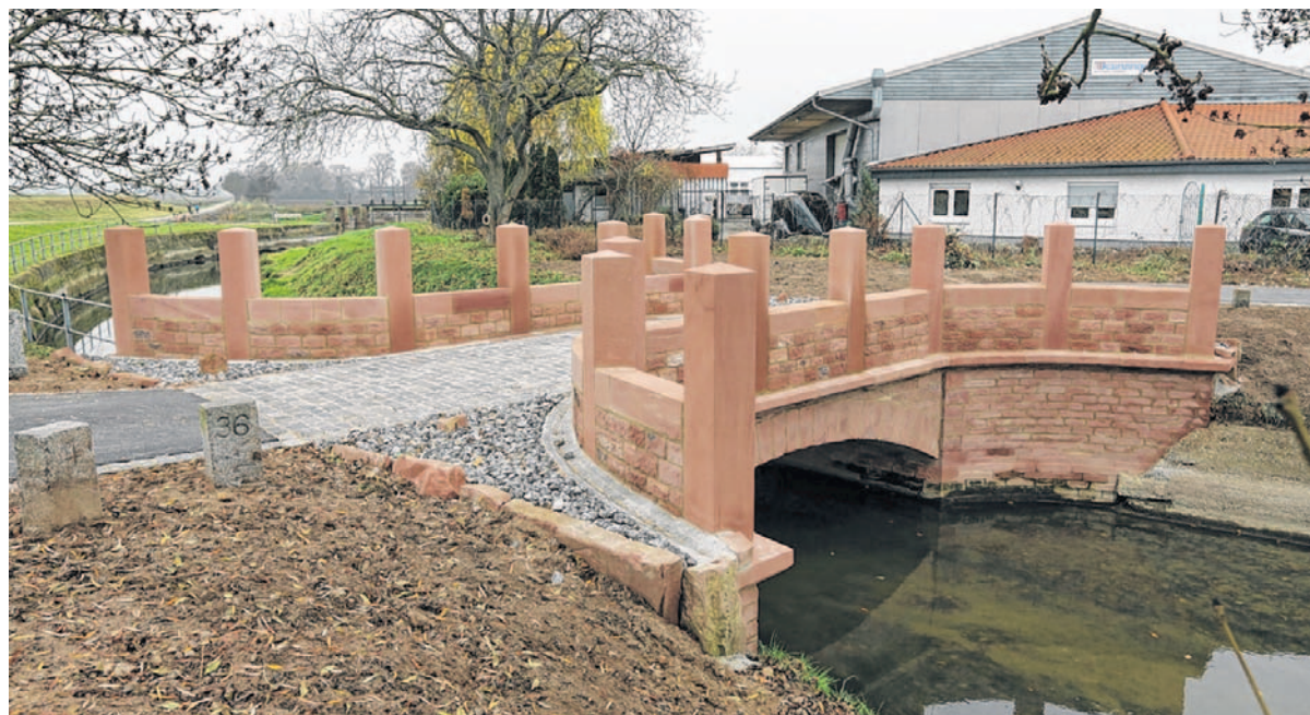
Nicht wiederzuerkennen: Die alte Kraichbachbrücke am Altwingertweg wurde für 35000 Euro saniert.
